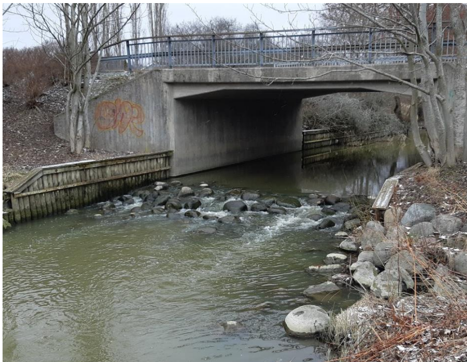
Figur 15. Upptröskling av vattennivån vid Västerleden ca 900 m uppströms befintligt dämme.
